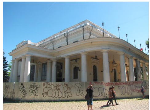
Foto 66 – pałac Woroncowa – w remoncie
