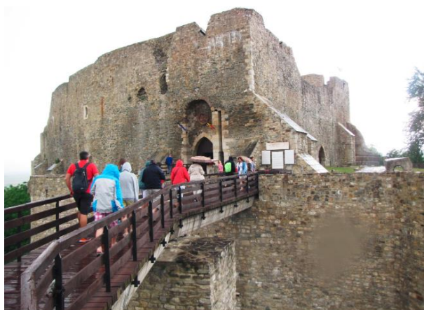
Foto 97 – w chodzimy do twierdzy pomostem w spartym przez kamienne podpory
